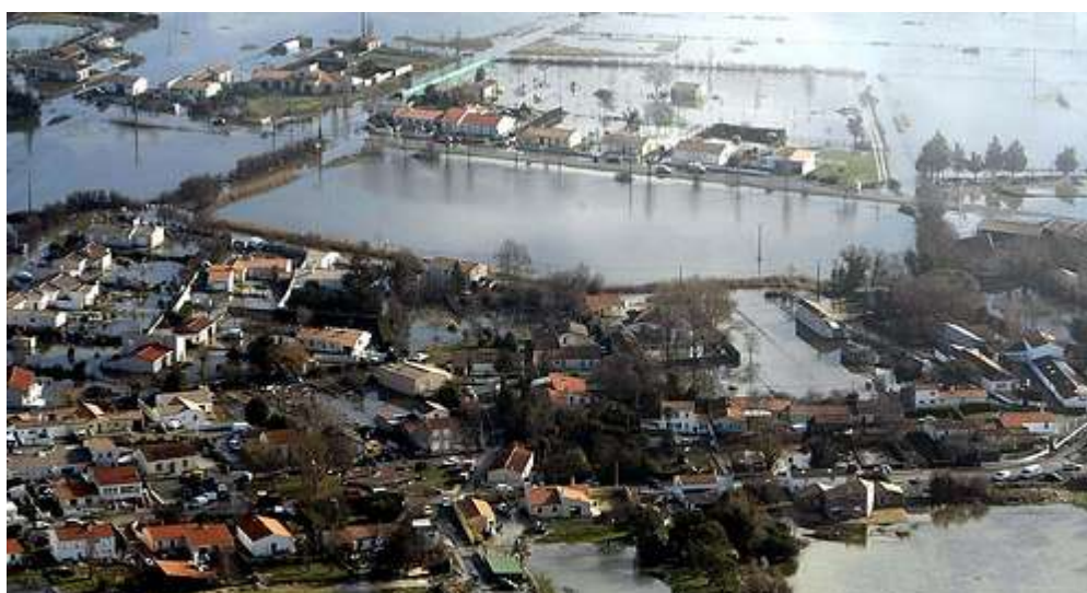
Dégâts provoqués par la tempête Xynthia 28 février 2010
