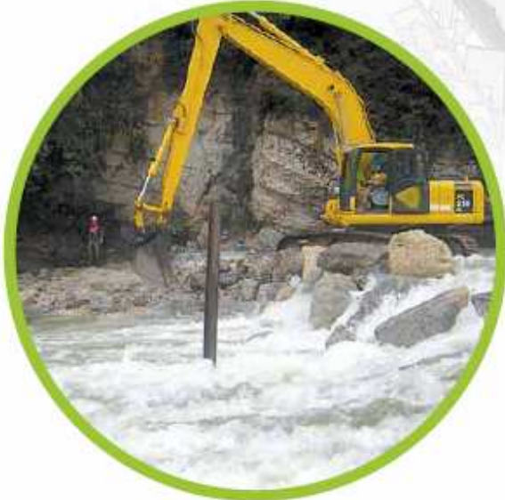
Aménagement et restauration des cours d'eau
