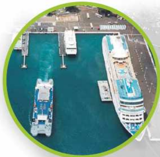
Génie civil et grands ouvrages
