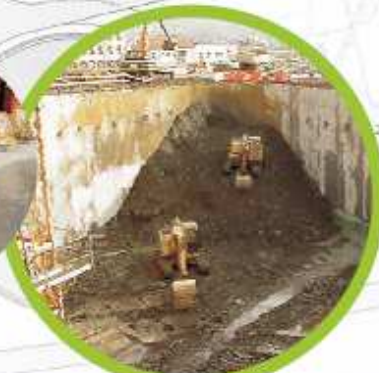
Bassin de rétention
