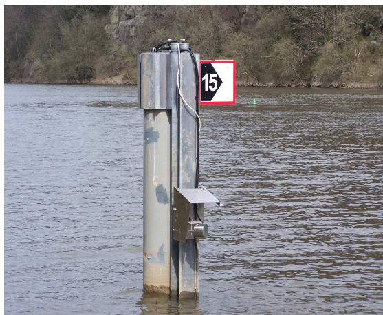
Station de mesure par ultrasons sur la Maine à Angers
