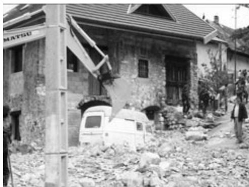
Coulée de boue rue des Méalans le 14 septembre 1994 - Source : Mairie de l'Argentière la Bessée
