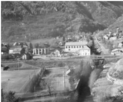
Torrent du Fournel, quartier du Quartz - Source : Mairie de l'Argentière la Bessée
