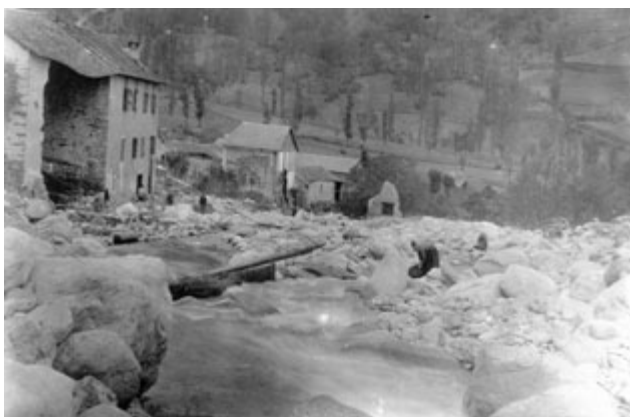
Mérens-les-Vals après la crue torrentielle du 28 juin 1902
