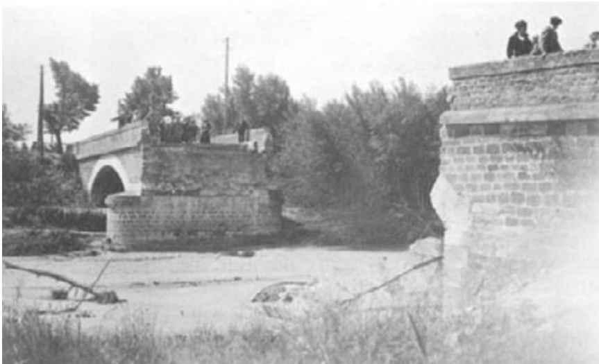
Pont sur la rivière Corone emporté lors de la crue de 1934 - Source : Le syndicat du bassin versant du Lez
