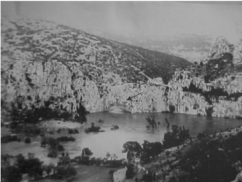
Le pont d'Arc pendant la crue de 1890 - Source : Le syndicat Ardèche Claire
