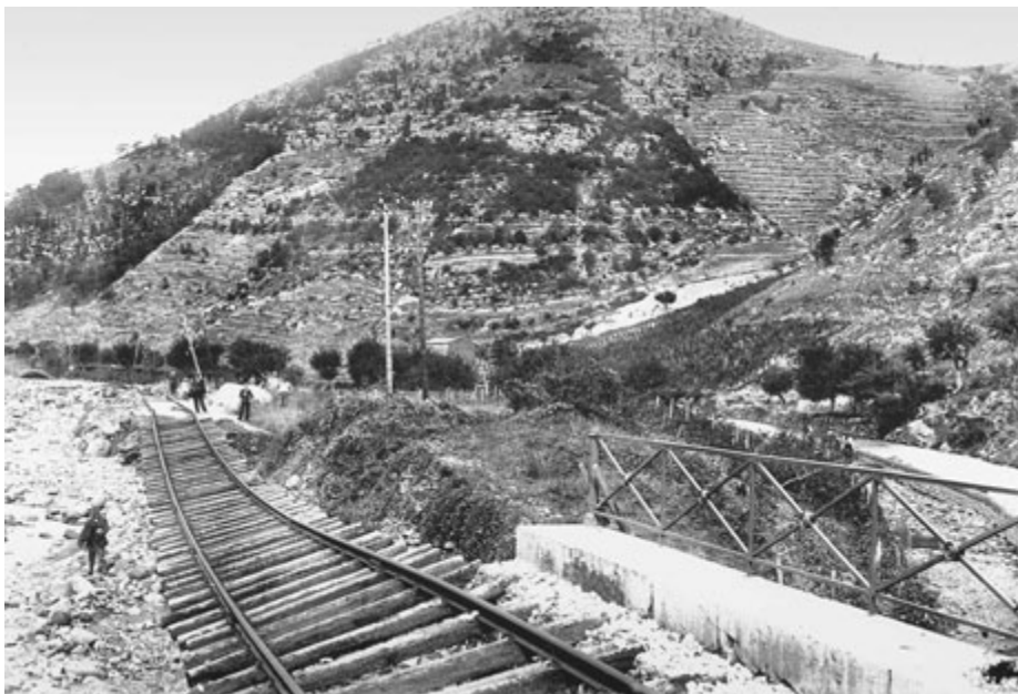
Photographie de Jules Bonnel montrant les effets des crues d'octobre 1907 sur la voie ferrée Privas-Alissas (ADA, 19Fi 51) - Source : Les Archives Départementales de l'Ardèche
