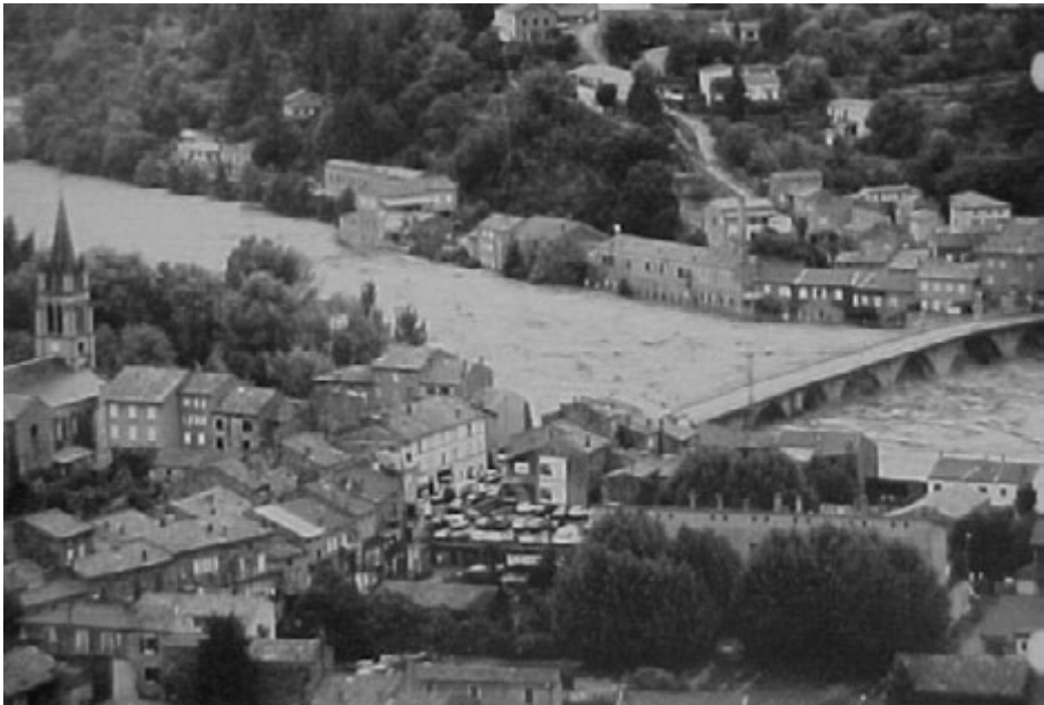
Le pont de l'Ucel pendant la crue du 22 septembre 1992 - Source : Le syndicat Ardèche Claire
